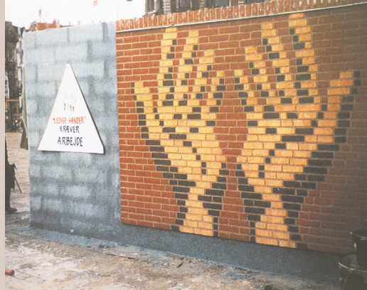
▲ Muren 'De ledige Hænder' står nyopført på Rådhuspladsen i august 1988. Murer i fuld gang med opførelsen ▼
